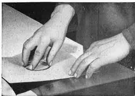
Kuva M 37. Männän renkaiden sivujen tasoittaminen sivuttaisvälyksen ollessa liian pieni
