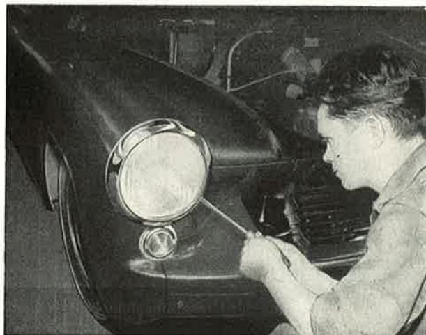
Kuva K 29. Uuden mallisen valonheittimen säätäminen
